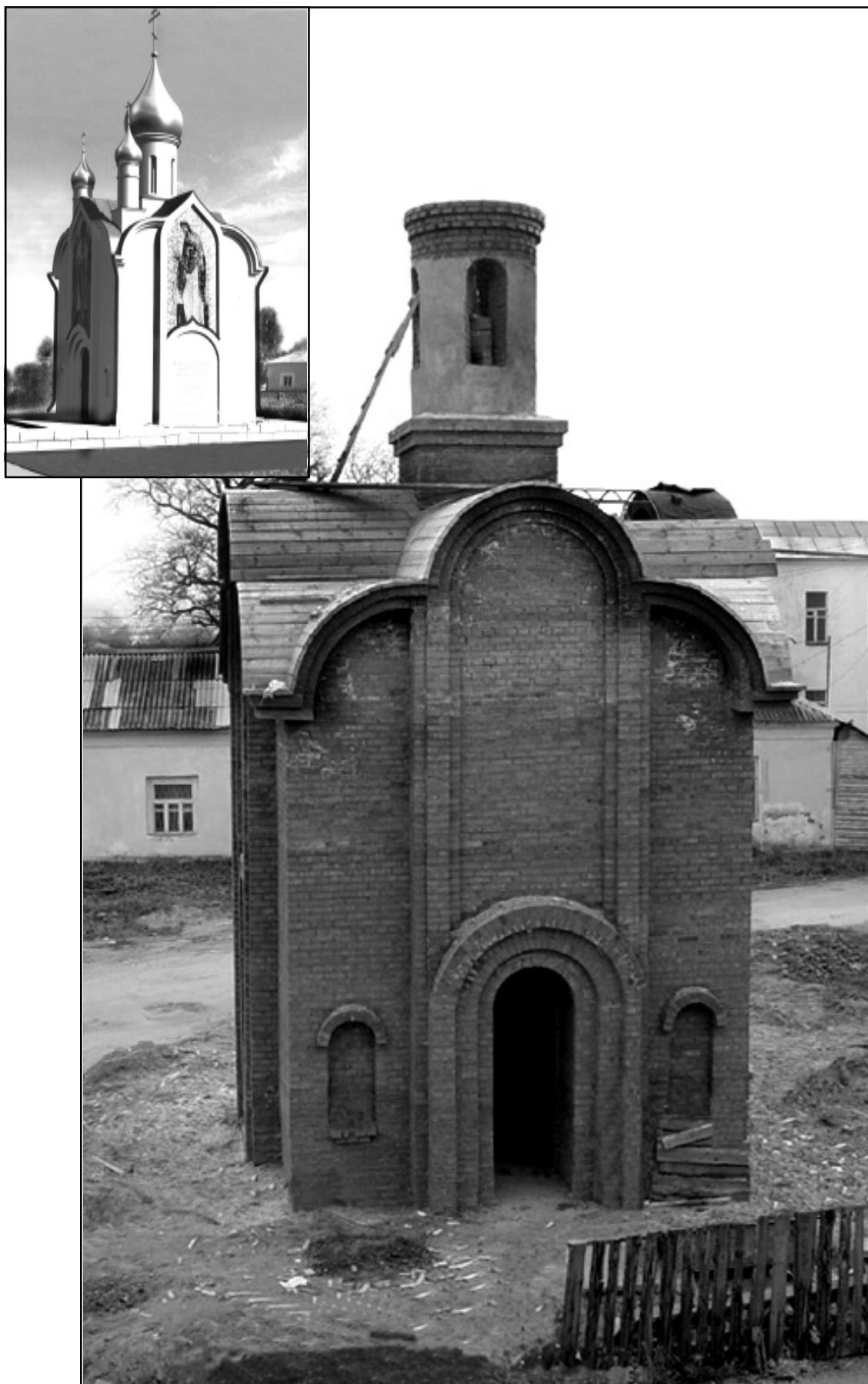
Строительство часовни во имя святых мучениц Феодоры и Евдокии в г. Боровске. 24 сентября 2003 г.
