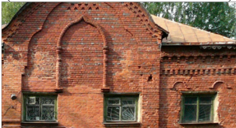
Рис. 5. Фрагмент южного фасада, 2016 г.
