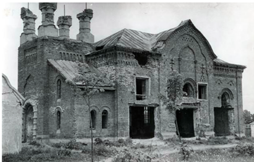
Рис. 3. Здание шуйской старообрядческой церкви, 1957 г. (фонд И. В. Шлепина, МУК «Литературно-краеведческий музей Константина Бальмонта» г. о. Шуя)
