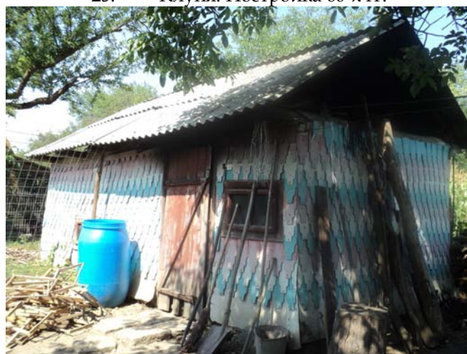
26. Баня. Постройка середины 20 в.
